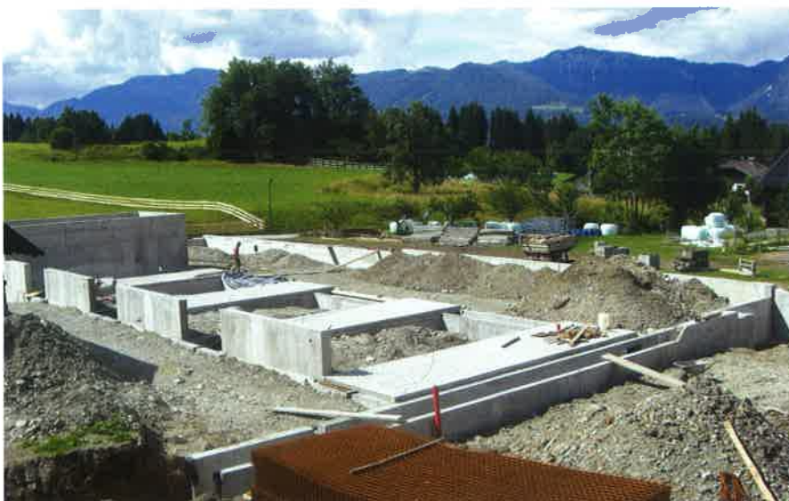
Aufgrund der Anordnung der Liegeboxen waren zusätzliche Güllekanäle mit Spaltenboden nötig.
