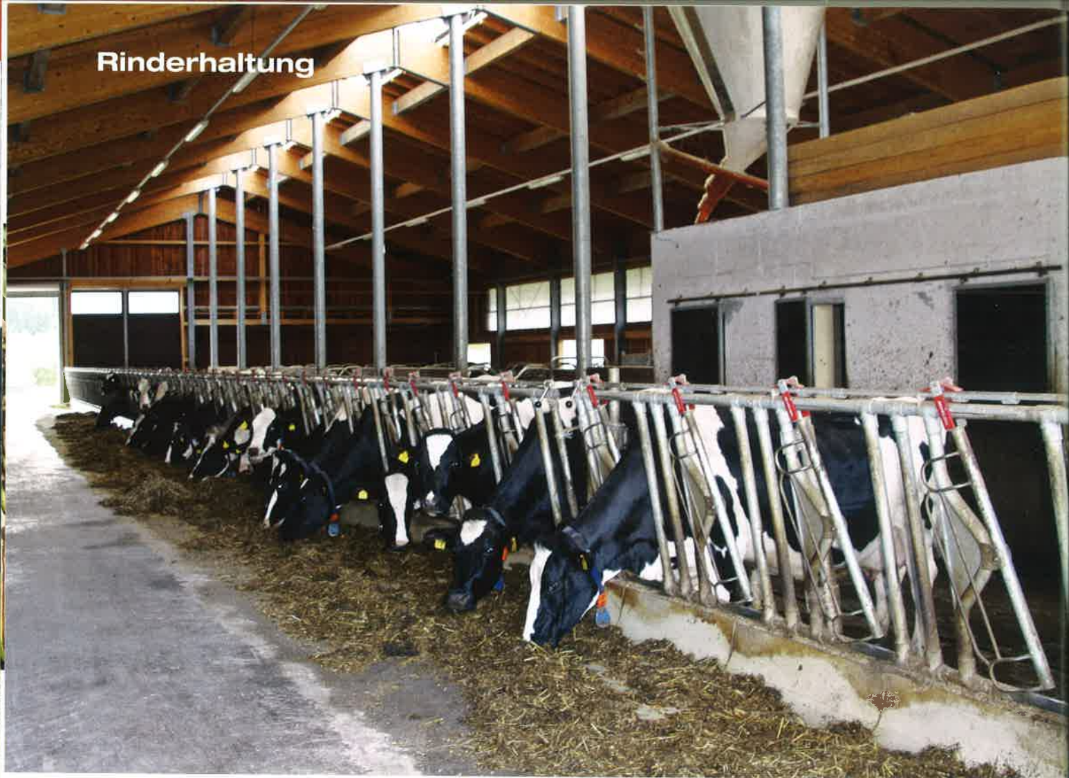
Die Futterachse des neuen Milchviehstalles ist einseitig befahrbar.
